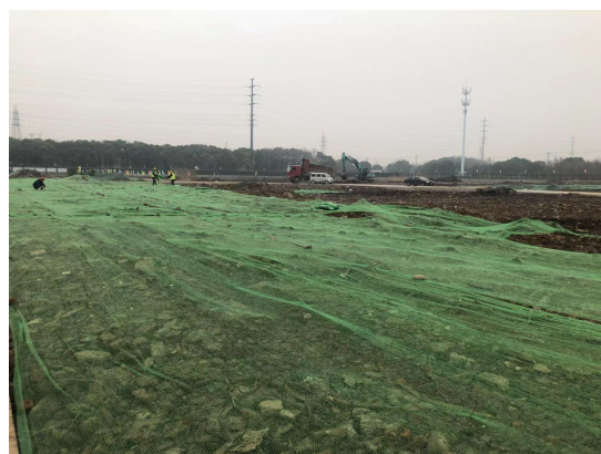
工程现场场地
