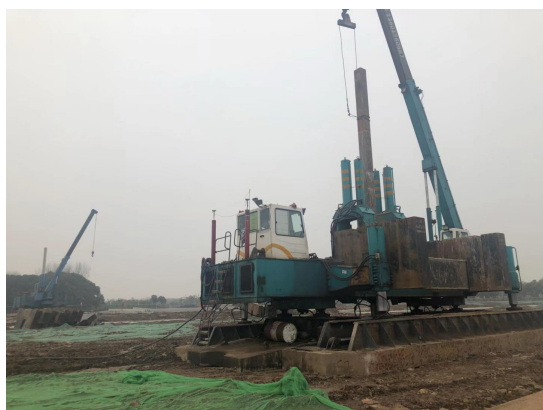
桩基正在施工
